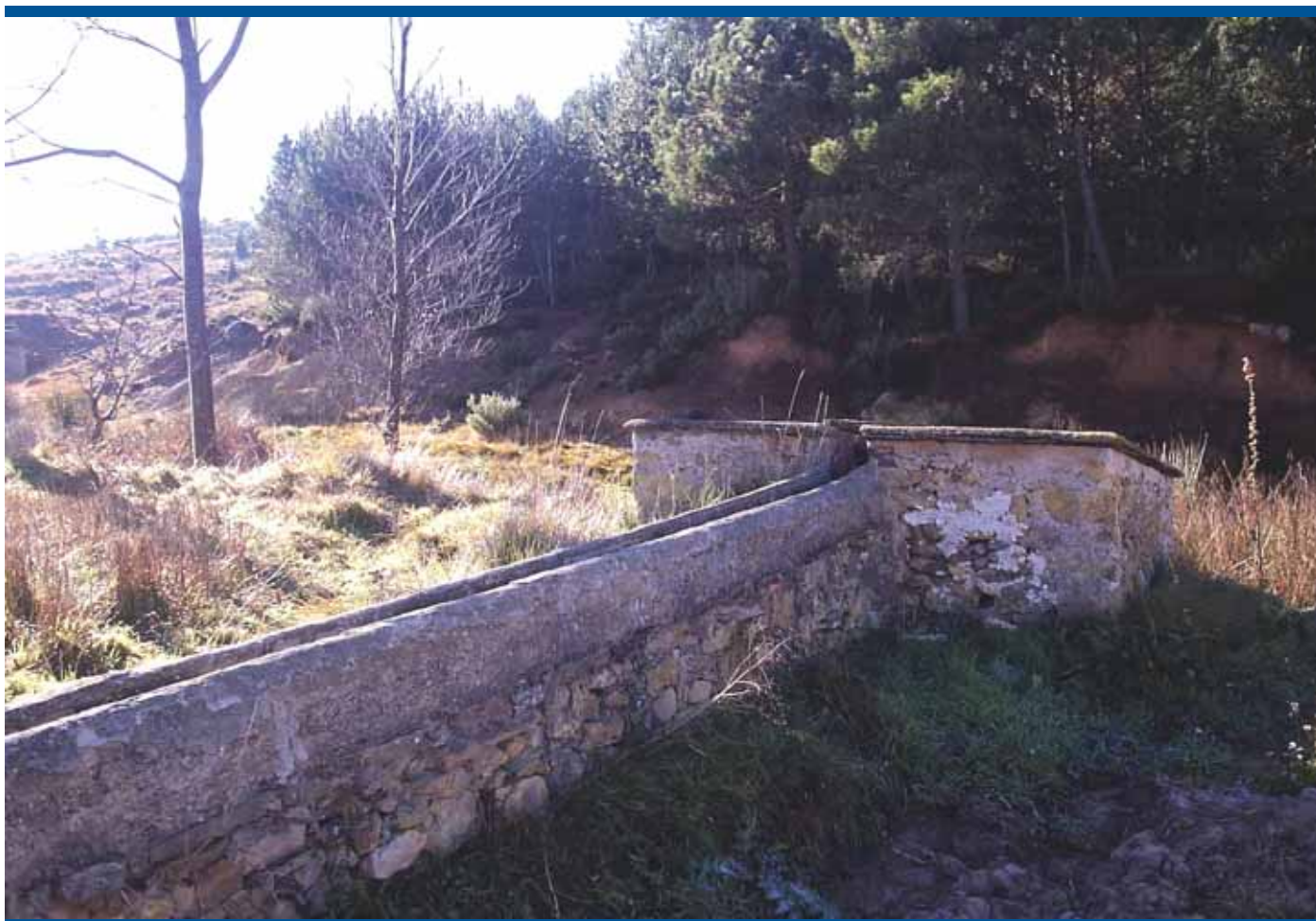
Noria y acequia del barranco de la Cañada (Pina de Montalgrao)
